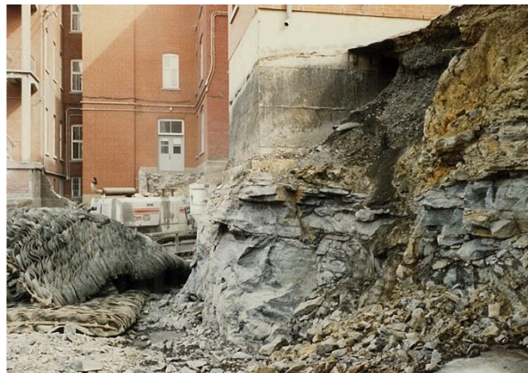
Vue du canal, partie arrière, au moment des travaux de 1987. Travaux de canalisation du canal.
