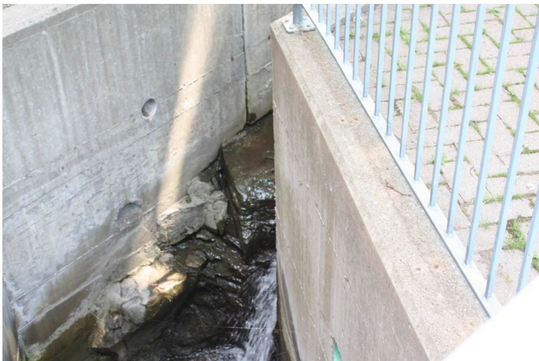
Le ruisseau à proximité de l'aile du Ruisseau, été 2014. 30
