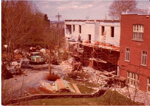
La façade arrière de l'aile du Ruisseau en construction en mai 1977. 22
