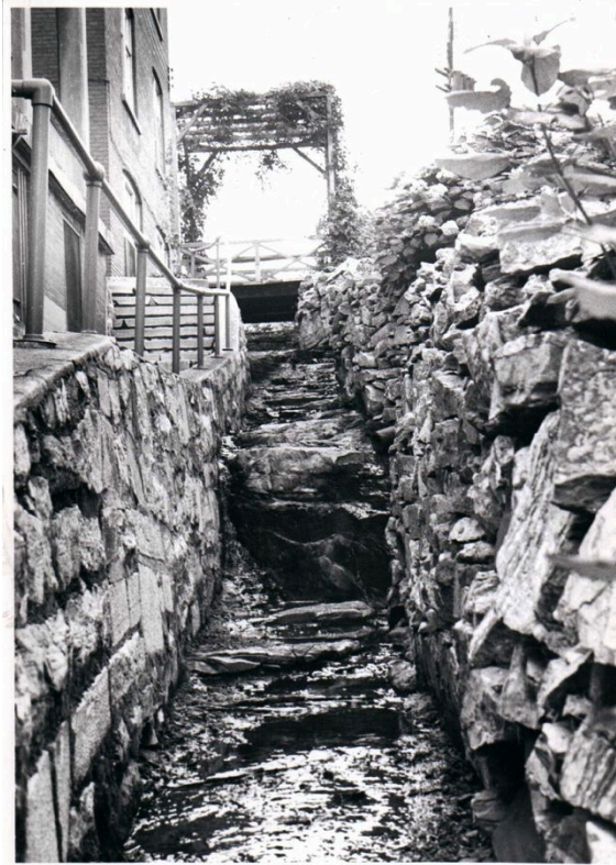
Le canal maçonné du ruisseau sur la propriété, date inconnue. 20
