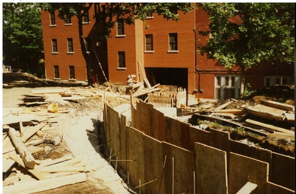
Vue du canal, partie arrière, au moment des travaux de 1987.
