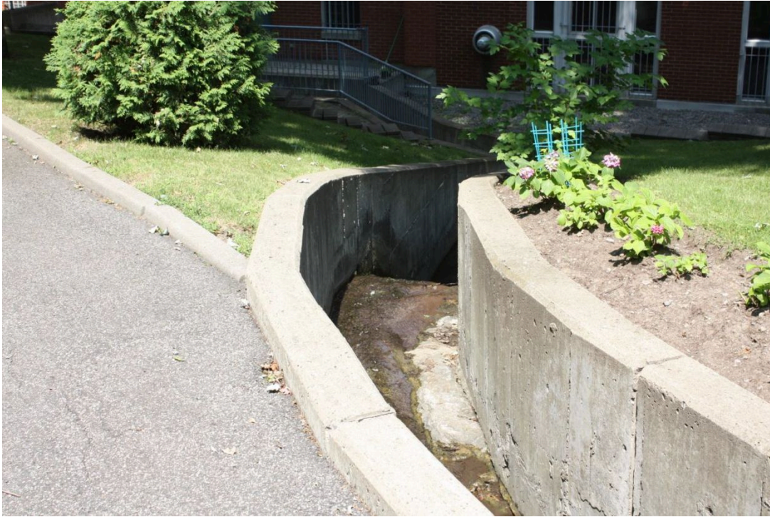
Le ruisseau à proximité de l'aile du Ruisseau, été 2014. 27
