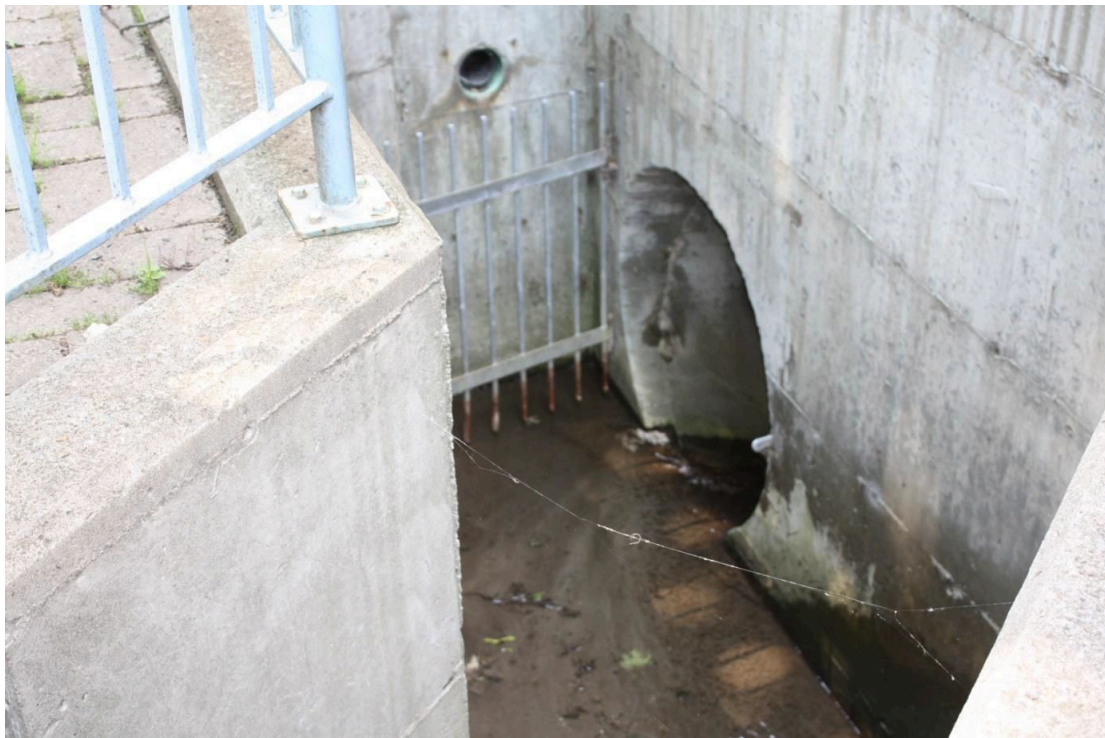
Le ruisseau à proximité de l'aile du Ruisseau, été 2014. 29
