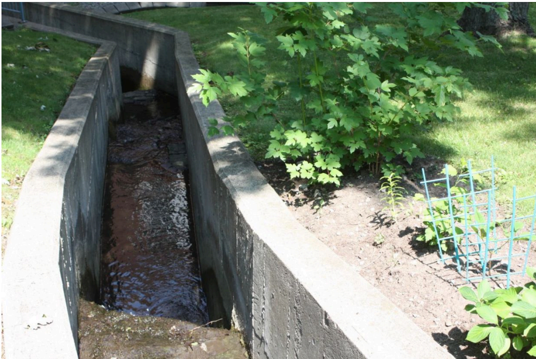
Le ruisseau à proximité de l'aile du Ruisseau, été 2014. 28
