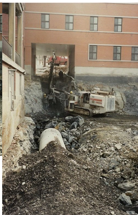
Vue du canal, partie arrière, au moment des travaux de 1987. Travaux de canalisation du canal.
