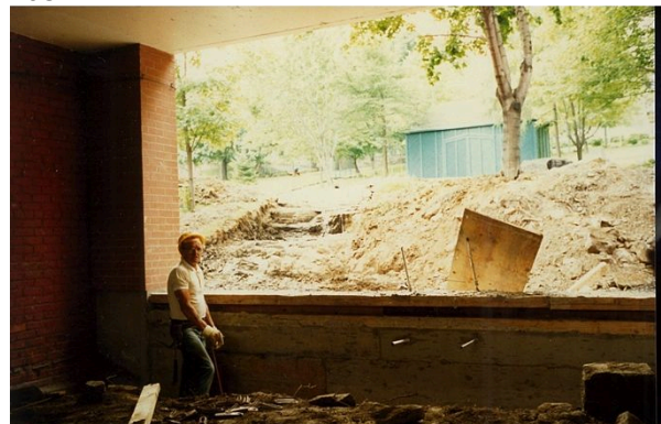
Vue du canal, partie arrière, au moment des travaux de 1987.
