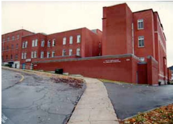
La nouvelle aile du côté Est en 1989 et la rénovation du premier agrandissement qui a eu pour effet entre autres l'élimination des galeries. Source : Archives des Sœurs Missionnaires de l'Immaculée-Conception, cote : 601-B1-3.
