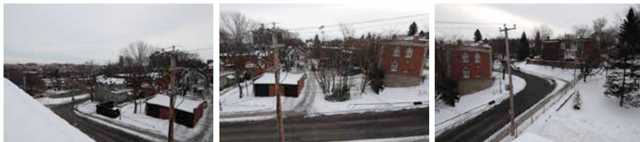
Présence des poteaux pour les réseaux le long de la côte du Vésinet. Source BRODEUR CONSULTANTS, janvier 2015.
