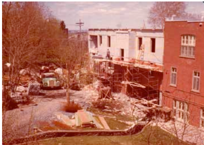
La façade arrière de l'aile du Ruisseau en construction en mai 1977. Source : Archives des Sœurs Missionnaires de l'Immaculée-Conception, cote : 601-B1-2.
