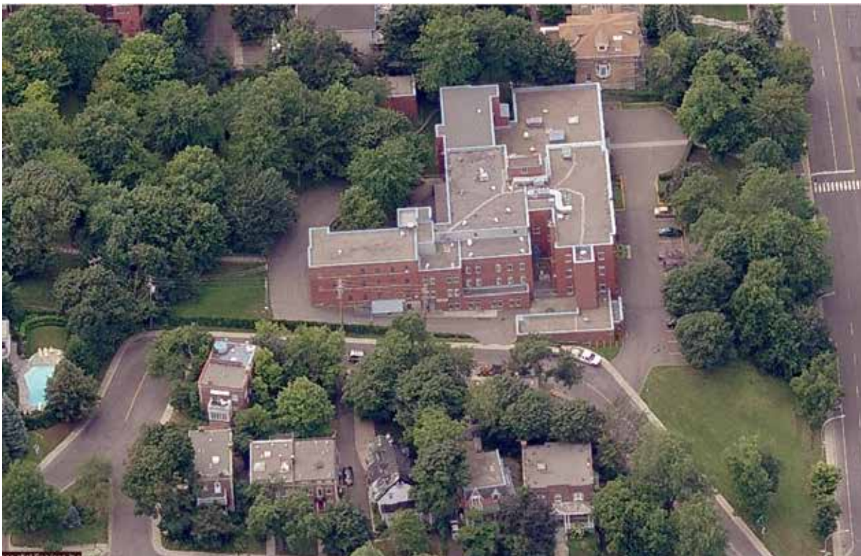
Vue oblique des façades Est. Source : Bing.
