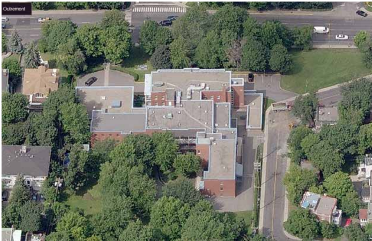
Vue oblique des façades Ouest. Source : Bing.
