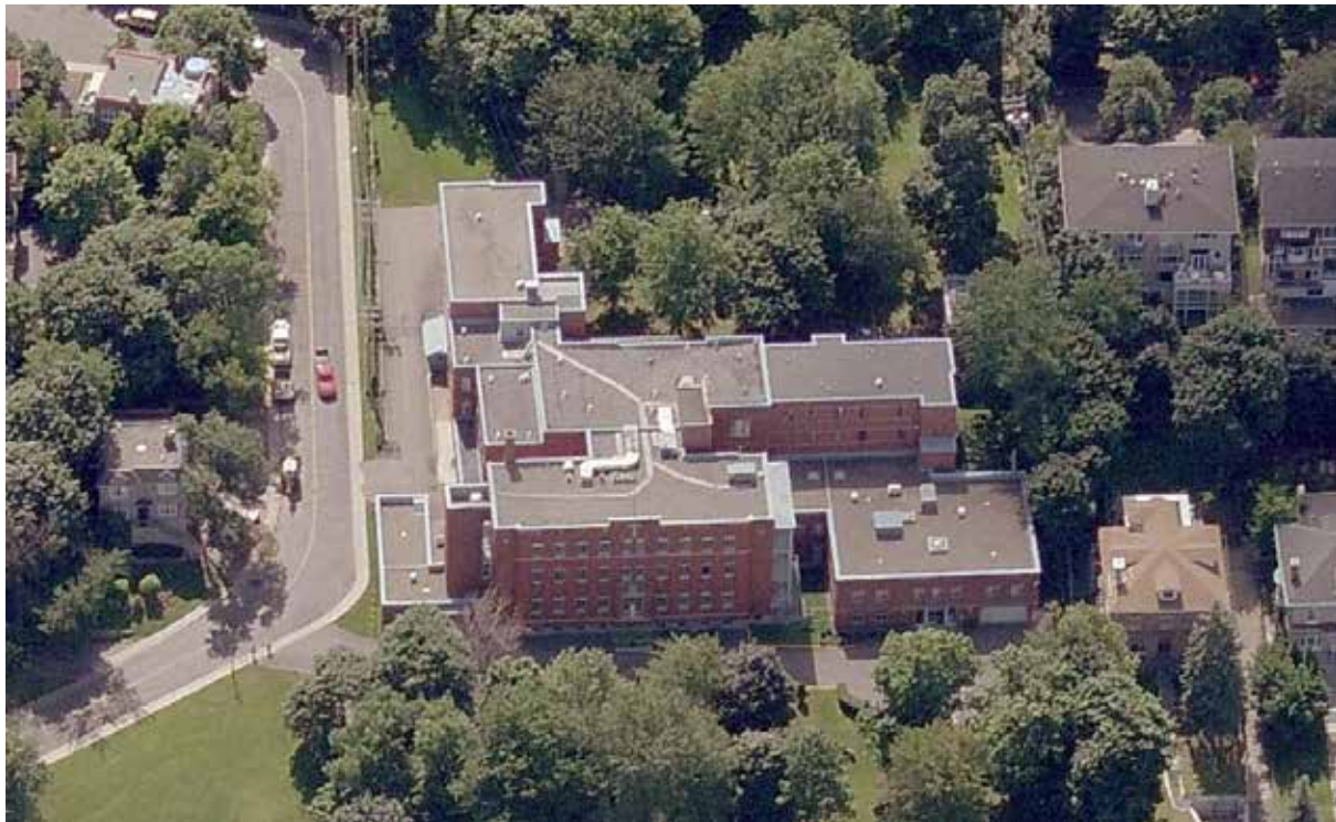
Vue oblique des façades principales. Source : Bing.
