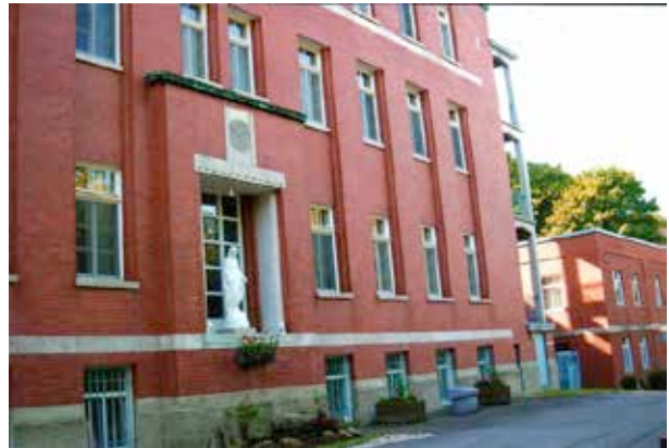
La façade du pavillon principal en 1989, qui a perdu son entrée. Source : Archives des Sœurs Missionnaires de l'Immaculée-Conception, cote : 601-B1-3.
